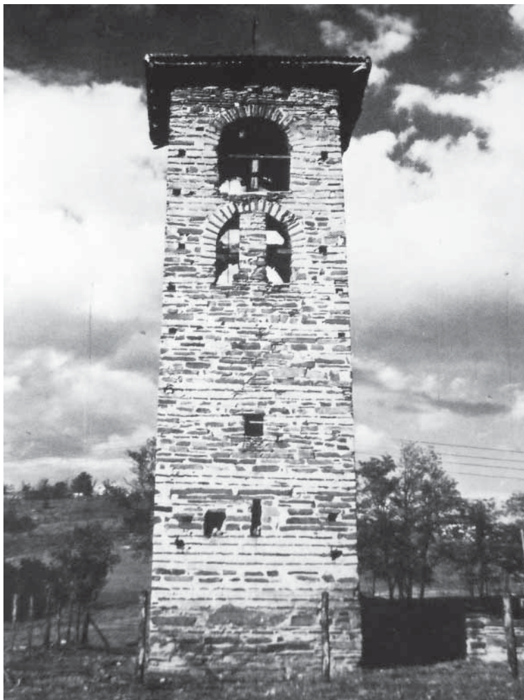
Сл. 3. Црква Св. Николе, изглед јужне куле пре реконструкције (према М. Чанак-Медић, Ђ. Бошковић, Архитектура Немањиног доба I) Fig. 3. Church of St. Nicholas, view of the south tower before reconstruction (after M. Čanak-Medić, Dj. Bošković, Arhitektura Nemanjinog doba I)
