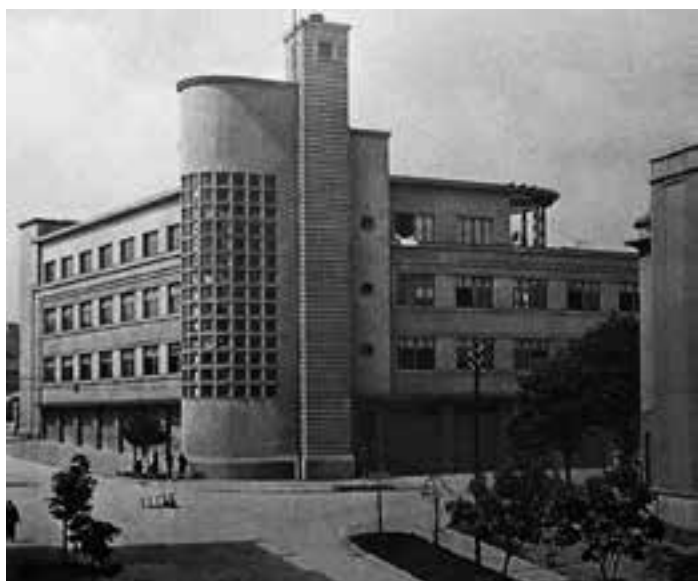
Сл. 21. Добривоје Пејтровић, Пожарна централа
