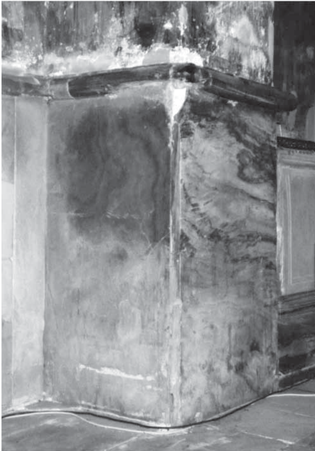
Сл. 5. Сїуденица, главна црква, оїлаїа на соклу југозаїадног ѿоїкуїолног ѿиласїира:
