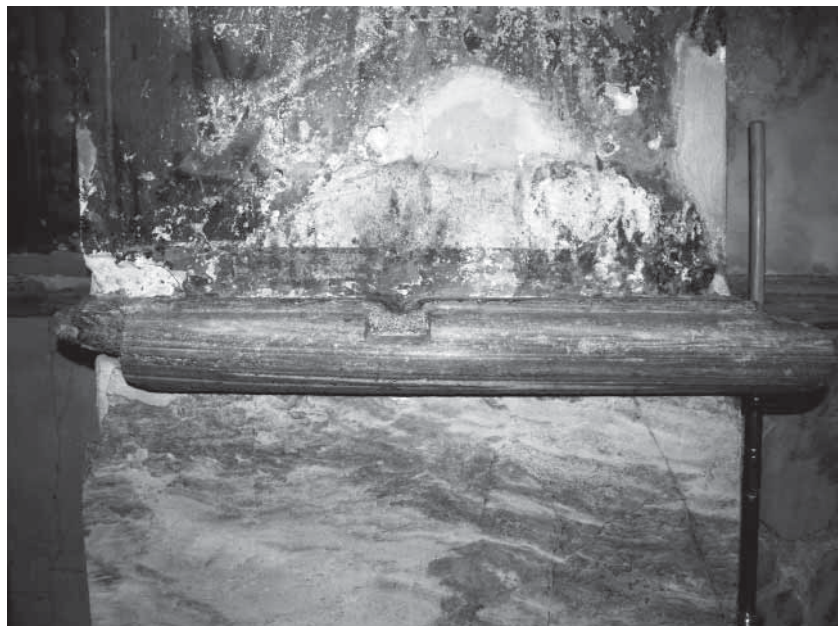
Сл. 9. Студеница, главна црква, венац југозајадног йоїкујолног йиласїра Fig. 9. Studenica, main church, southwest dome-supporting pilaster, dado rail
