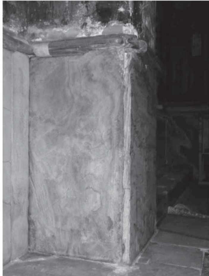
Сл. 5. Сїуденица, главна црква, оїлаїа на соклу југозаїадног ѿоїкуїолног ѿиласїира:
