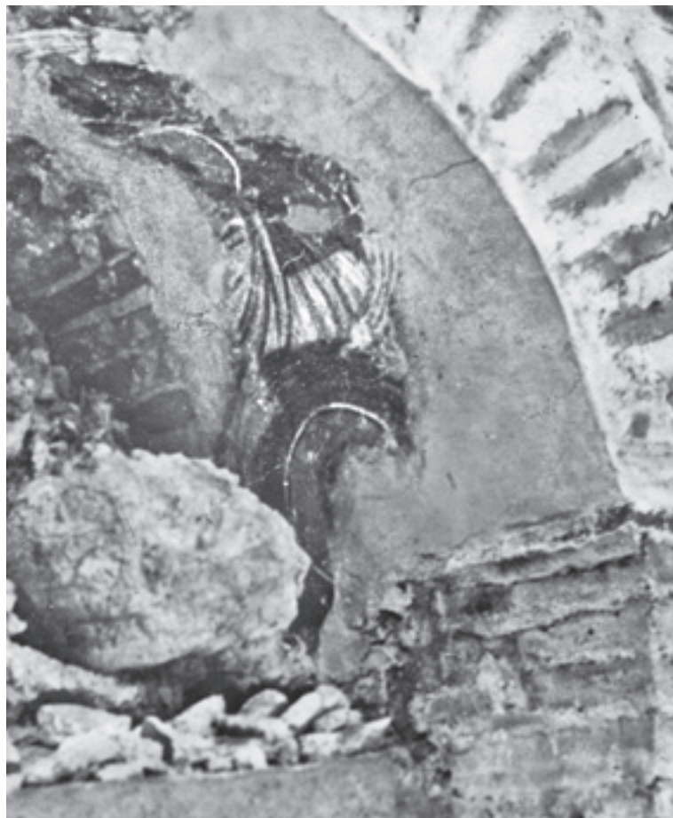
Сл. 10. Остаци покривајући лика светог на јужној страни лука северног отвора прве бифоре с јужне стране на западној фасади Fig. 10. Remnants of busts of saints. Western façade, first two-light opening looking from the south to the north, southern side of the soffit of the northern opening arch
