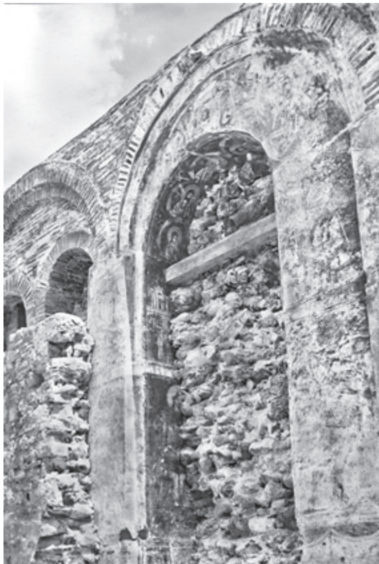
Сл. 2. Прва два лучна отворора с јужне стране на западној фасади у току конзерваторско-реставраторских радова Fig. 2. First two arched openings looking from the south to the north on the western façade during conservation-restoration works
