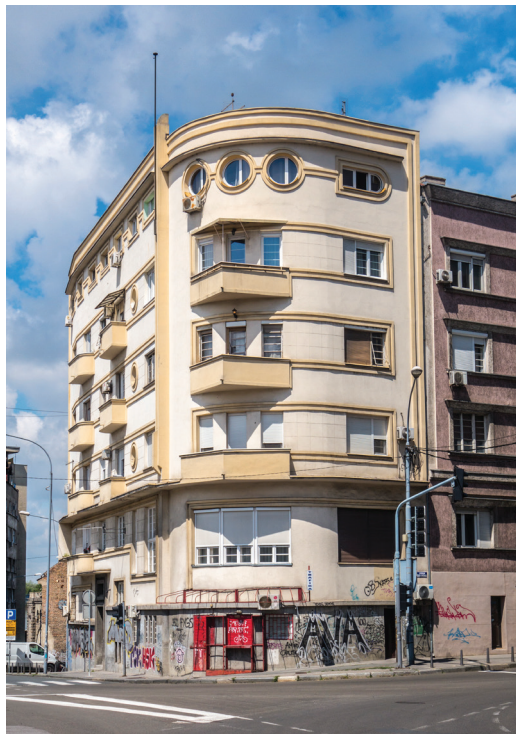
Сл. 4. Зграда ренџијерке Хрисанџије Балужић на углу Пој Лукине и Црногорске улице, 1935. (фотографија: В. Пујић Прица)
