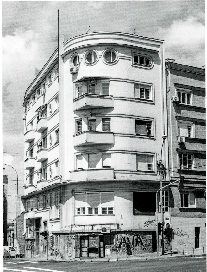
2. Стамбена зграда Хрисанте Балугџић на углу Поп Лукине и Црногорске улице у Београду, 1935 (фото: Владана Пуџић Прица)
