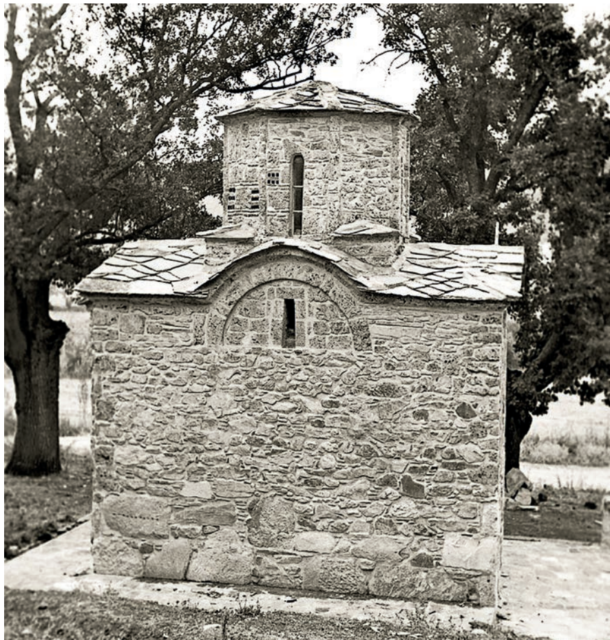
Сл. 5. Северна фасада FIG. 5. NORTHERN FAÇADE
