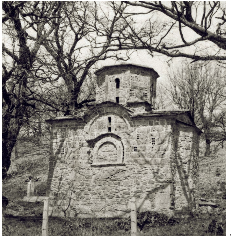
Сл. 6. Јужна фасада FIG. 6. SOUTHERN FAÇADE
