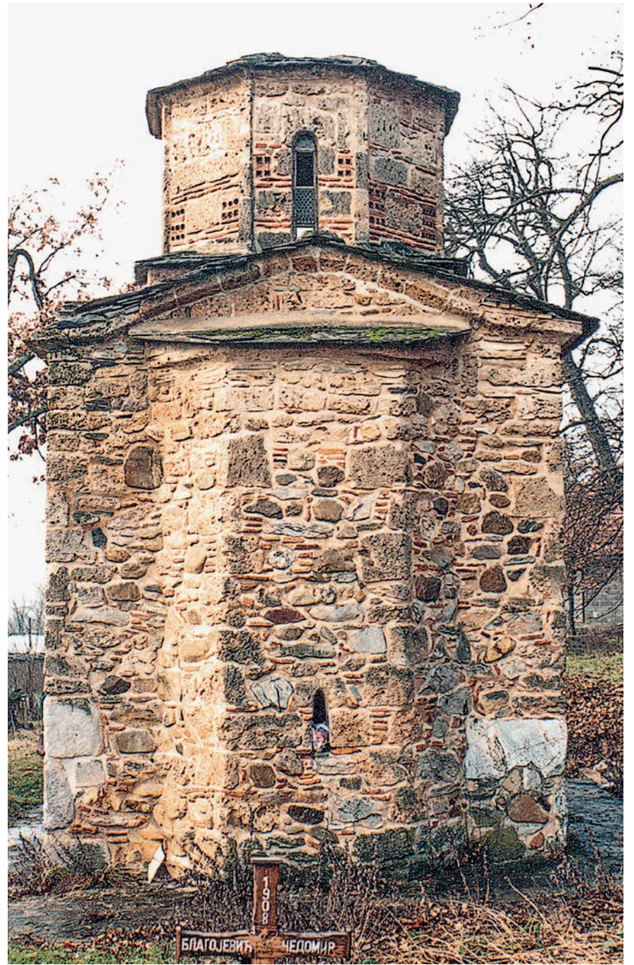
Сл. II. Источна фасада FIG. II. EASTERN FAÇADE
