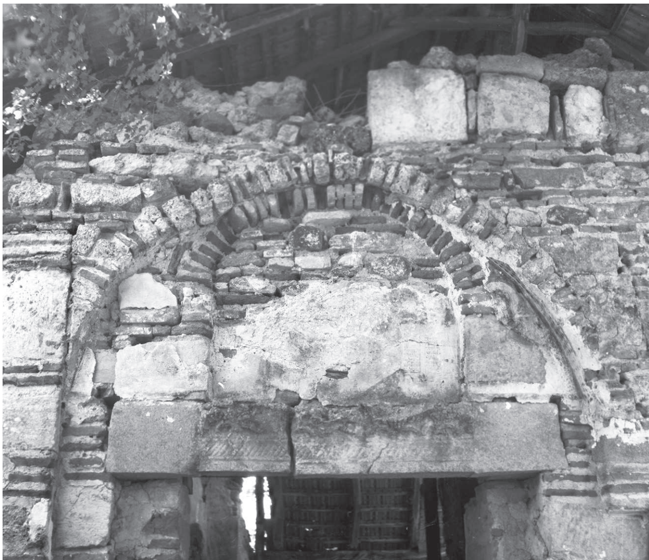
СЛ. 10. ДЕО ЗАПАДНЕ ФАСАДЕ ХРАМА, СТАЊЕ ИЗ 1968, СНИМАК ПЗЗСК ИЗ ПРИШТИНЕ
