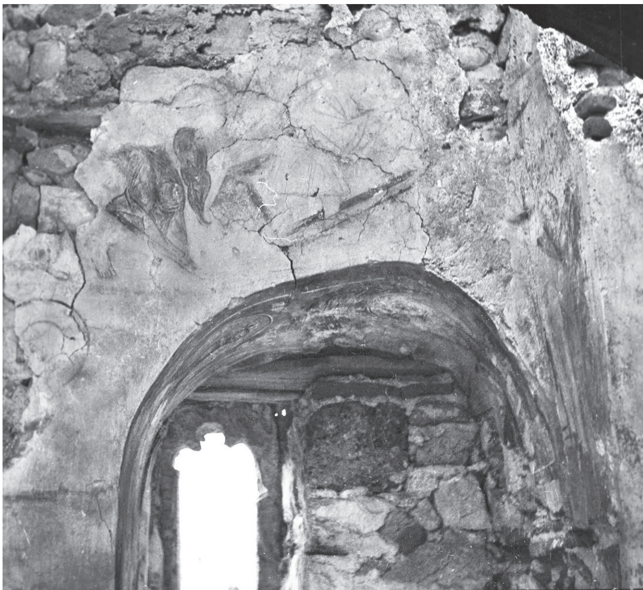
СЛ. 14. ЗИД НАД СЕВЕРОИСТОЧНИМ ЛУКОМ, СТАЊЕ ИЗ 1968, СНИМАК ПЗЗСК ИЗ ПРИШТИНЕ
