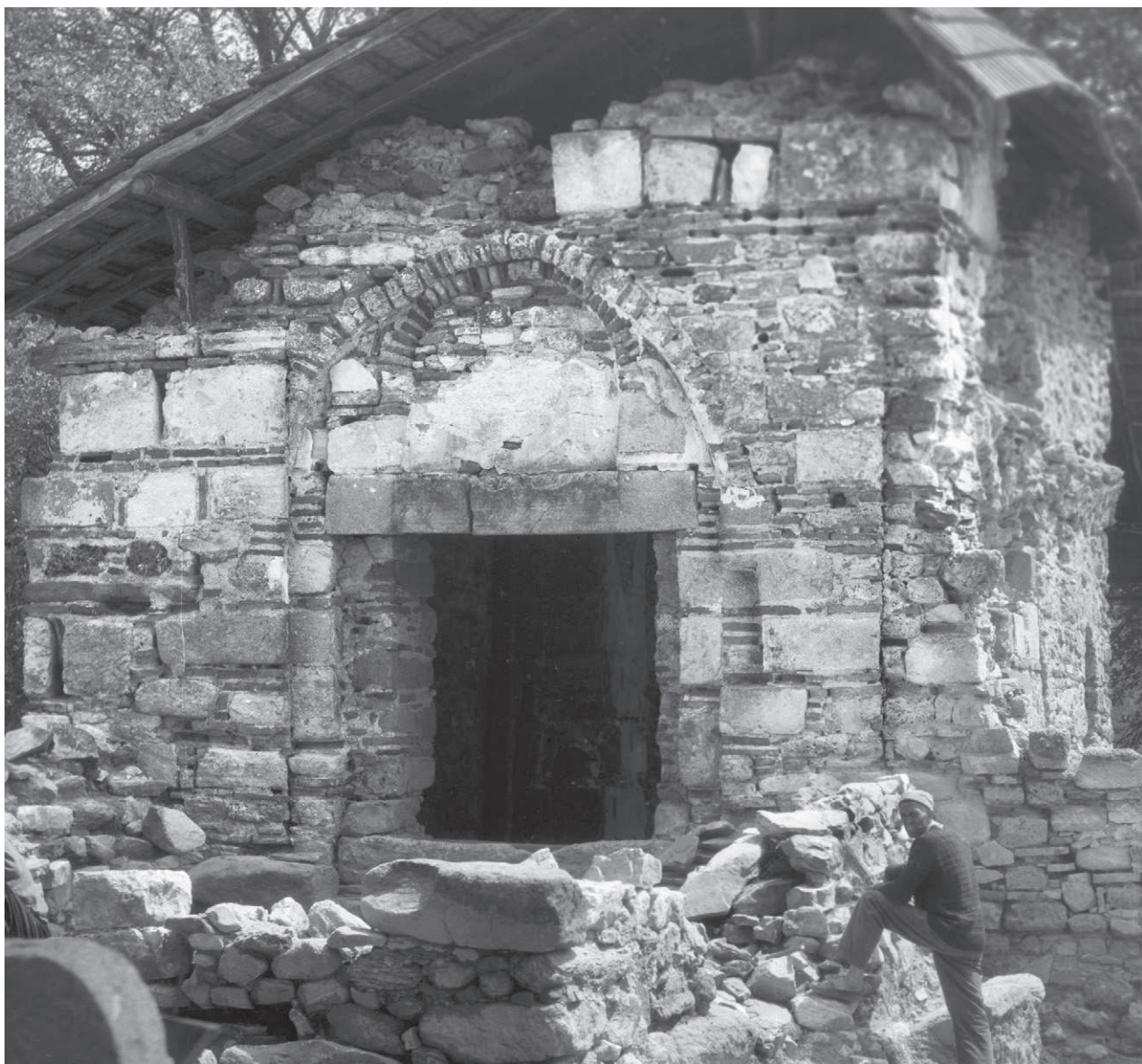
СЛ. 9. ПОГЛЕД НА ЗАПАДНУ ФАСАДУ ХРАМА, СТАЊЕ ИЗ 1968, СНИМАК ПЗЗСК ИЗ ПРИШТИНЕ
