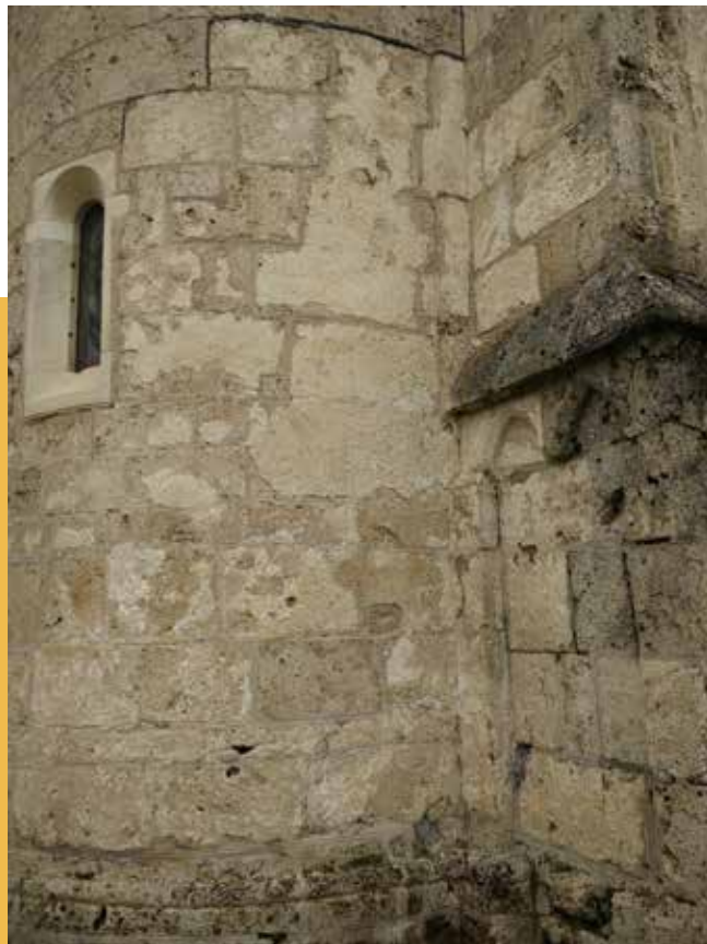
▲ 39. Детаљ оригиналног, фино углачаног, танког, кречног, благо тонираног малтера, који се још увек задржао на појединим местима фасаде / Détail de l'enduit original finement poli, fin, à la chaux et légèrement teinté qui persistait encore à certains endroits de la façade. / Detail of the original polished, thin, softly colored lime mortar that can still be seen in some places on the façade.
