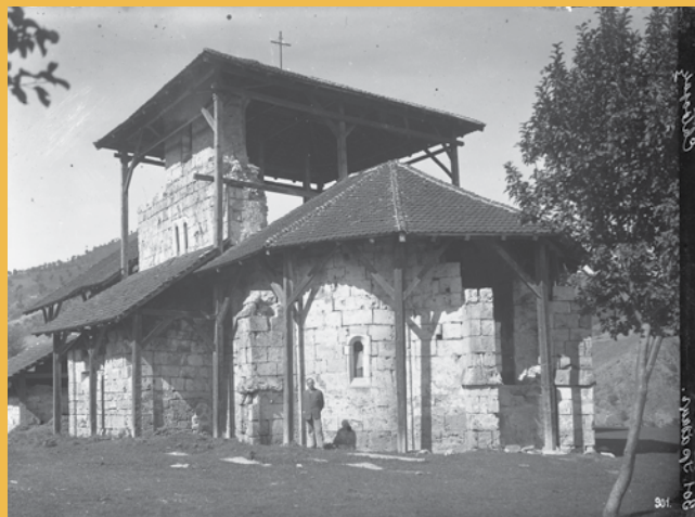
▲ 20. Заштитни кров, подигнут изнад храма 1913. године. / Toit de protection construit en 1913. / Protective roof installed above the church in 1913.
