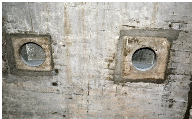
Sl.2. Bliski pogled na dva rezonatora u kupoli - levo je manji, a desno veći rezonator.
