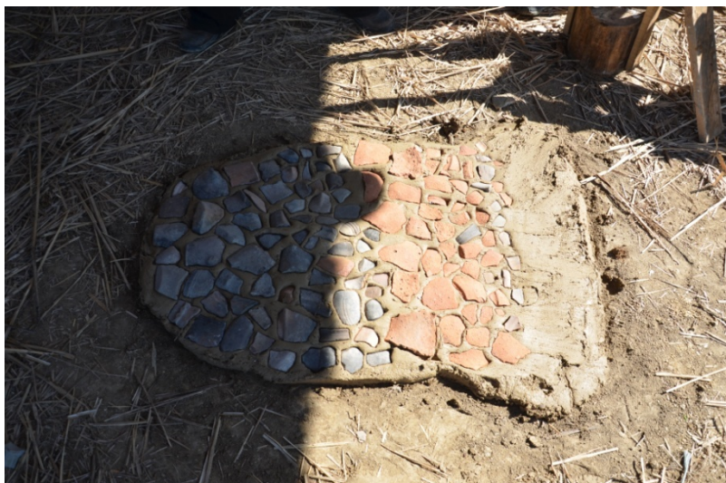
Slika 169. Supstrukcija podnice (foto: a. Đuričić)
