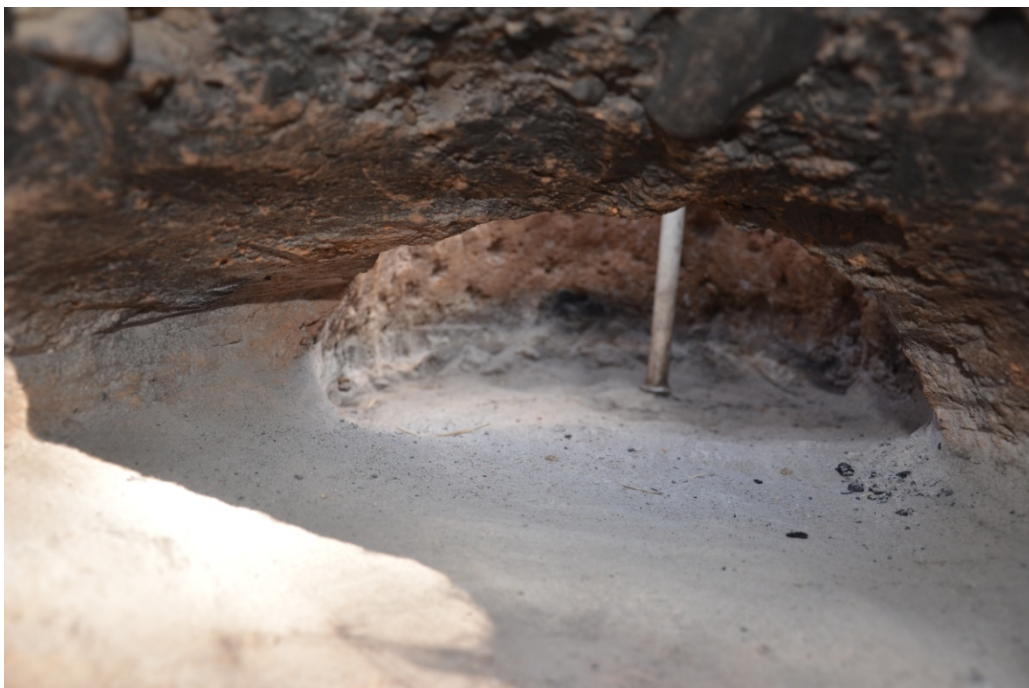
Slika 160. Izgled unutrašnjosti donjeg dela peći sa dimnjakom u Trsteniku nakon intenzivne upotrebe – pogled kroz otvor ložišta (foto: A. Đuričić)
