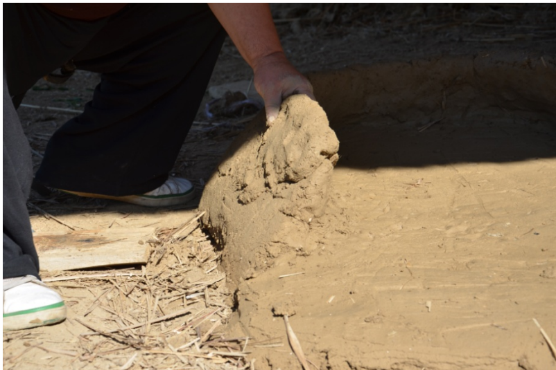
Slika 172. Zidanje kalote u tehnici pločica (foto: A. Đuričić)
