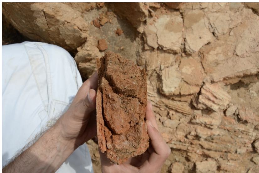
Slika 101: Spojevi između pločica (Foto-dokumentacija Vinča Projekta)
