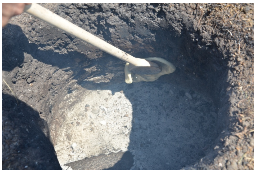
Slika 192. Lepljenje lepinje na zid peći (foto: A. Đuričić)
