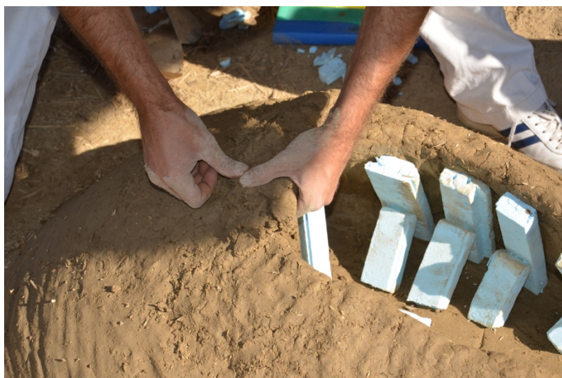
Slika 176. Izrada zadnjeg dela vrha kalote u tehnici pločica (foto: A. Đuričić)
