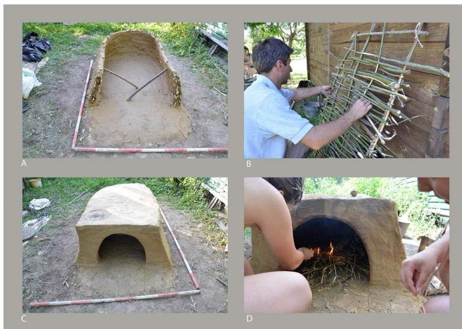
Slika 167a-d. Izrada kalote eksperimentalne peći (foto: A. Đuričić)
