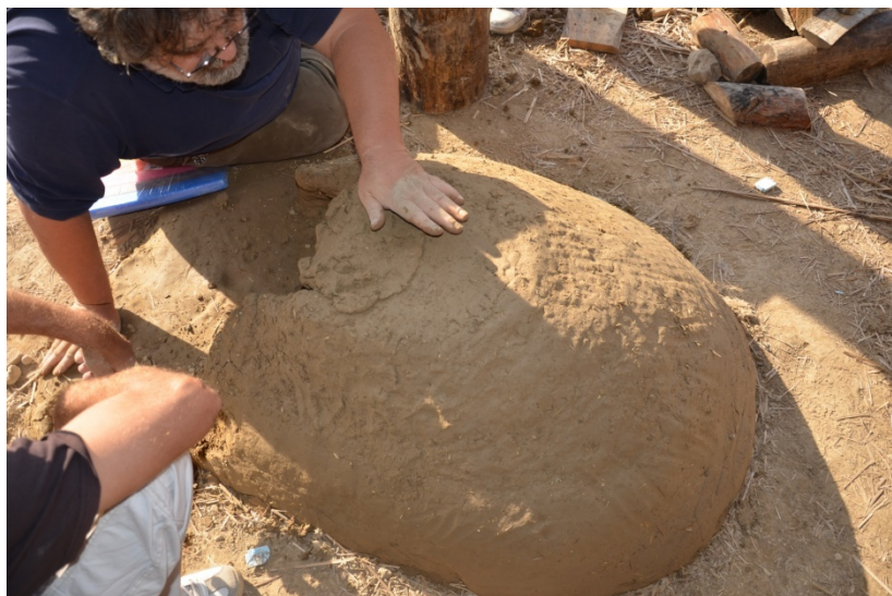
Slika 178. Izrada prednjeg dela vrha kalote (foto: A. Đuričić)
