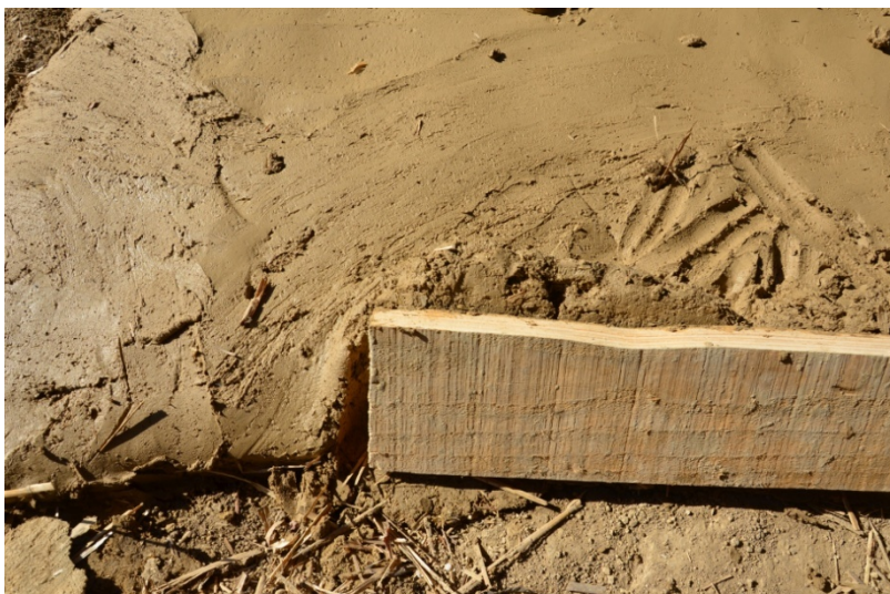
Slika 173. Sabijanje podnice daskom (foto: A. Đuričić)
