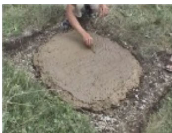
Slika 135. Apliciranje gline preko supstrukcije (Buzea et al. 2008: 229)
