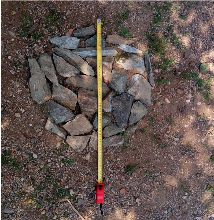
Slika 125. Poređan kamen za supstrukciju (foto: A. Đuričić)
