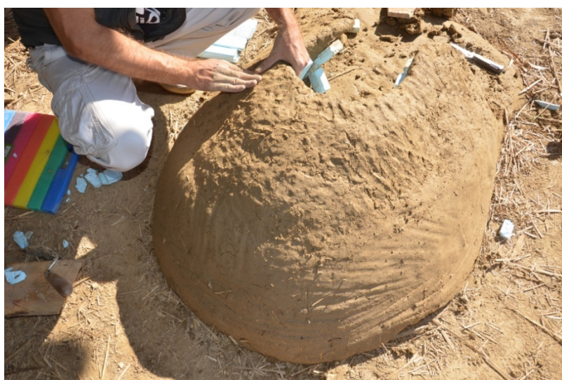
Slika 177. Izrada vrha kalote u tehnici pločica (foto: A. Đuričić)
