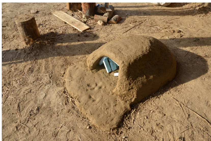
Slika 179. Gotova peć sa ravnim vrhom kalote (foto: A. Đuričić)
