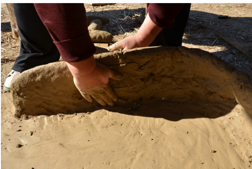
Slika 175. Sjedinjavanje unutrašnjih pločica (foto: A. Đuričić)
