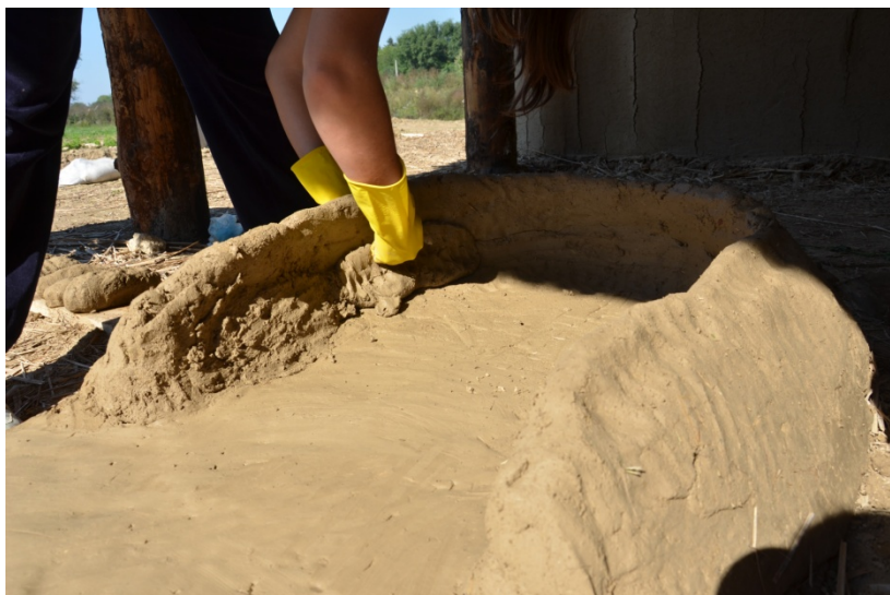
Slika 174. Ojačavanje kalote peći (foto: A. Đuričić)
